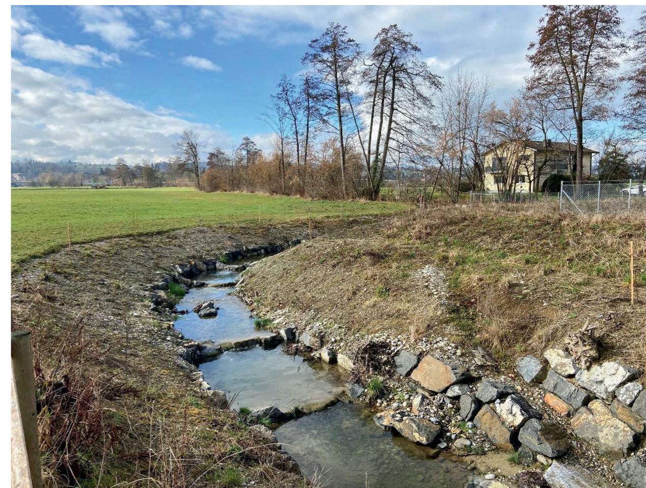
Das neue Gerinne des Schwärzibachs oberhalb der Eisenbahnstrasse
